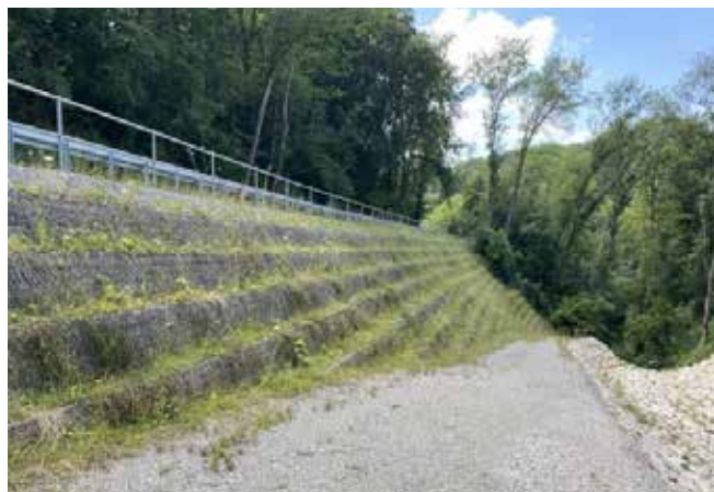
Abb. 4: Zustand Sanierungsabschnitt mit bewehrter Erde mit Begrünung. Quelle: Eigene Aufnahme.
