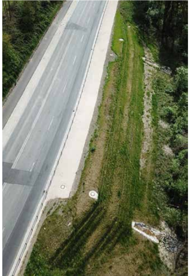
Abb. 7: Fertiggestellte Konstruktion mit Begrünung. Quelle: Dipl.-Ing. (FH) Matthias Schwalb, TAUW GmbH Niederlassung Regensburg
