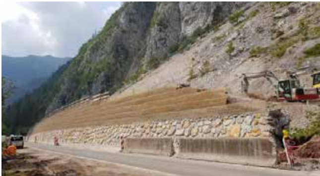
Abb. 9: Schutzwall während des Baus. Quelle: Maccaferri Central Europe s.r.o.
