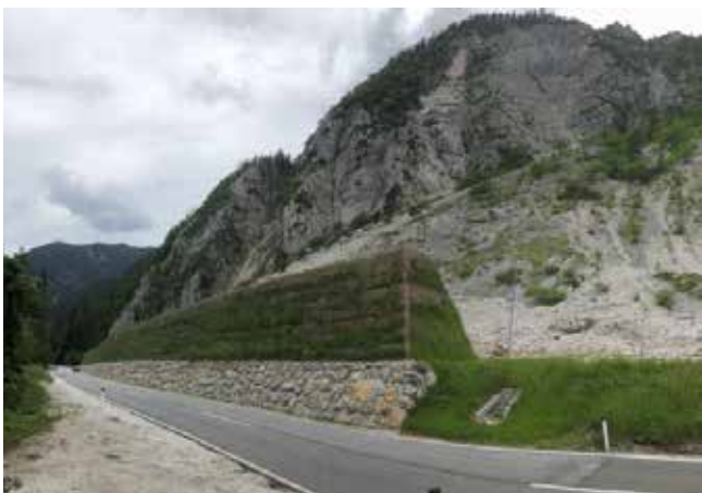
Abb. 10: Schutzwall nach Fertigstellung. Quelle: Maccaferri Central Europe s.r.o.
