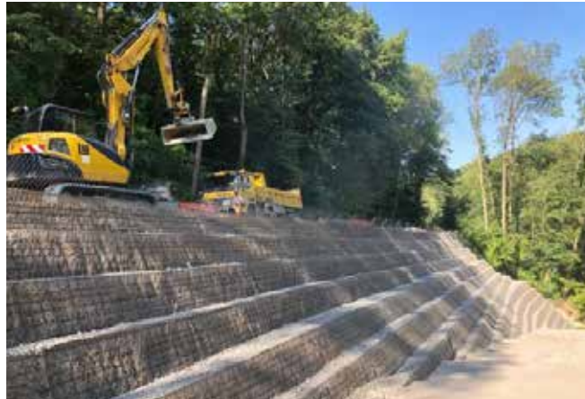
Abb. 3: Zustand Sanierungsabschnitt mit bewehrter Erde. Quelle: Eigene Aufnahme.
