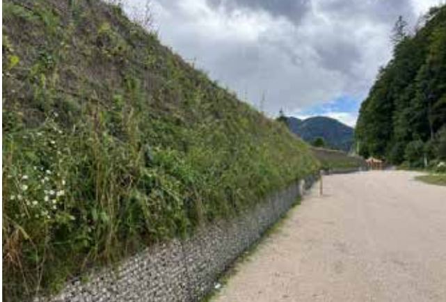
Abb. 13: Fertiger Wall mit einsetzender Begrünung. Quelle Eigene Aufnahme.
